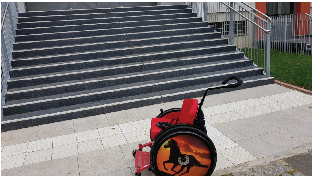
Frisch sanierter Treppenaufgang (ohne Rollstuhlrampe)
